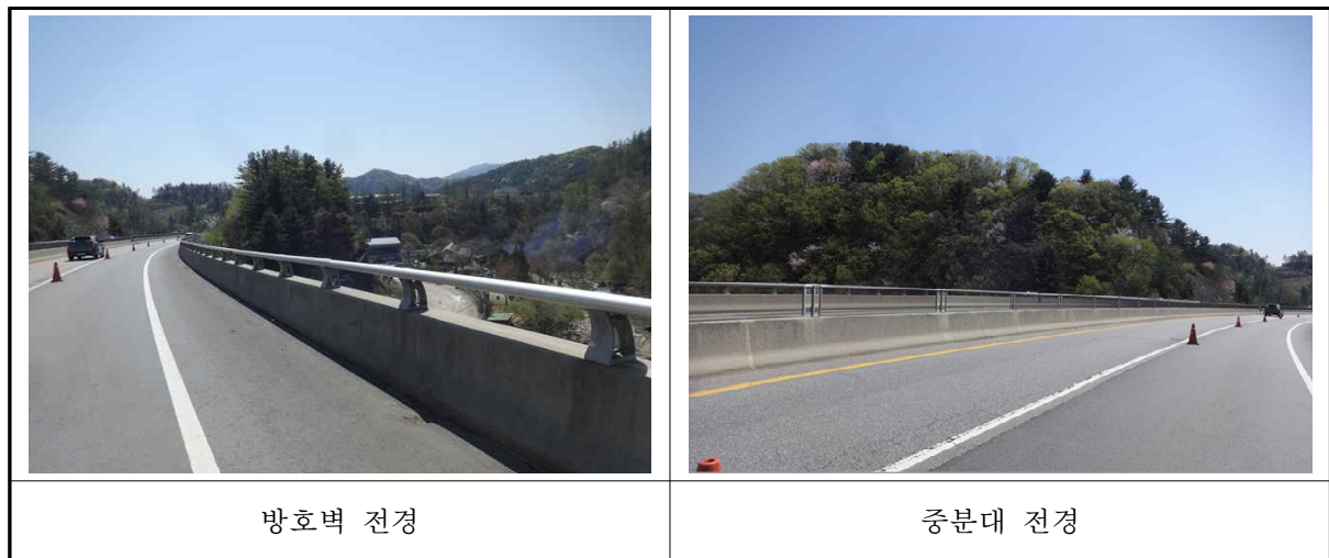
〈사진 3.4〉 방호벽 전경
