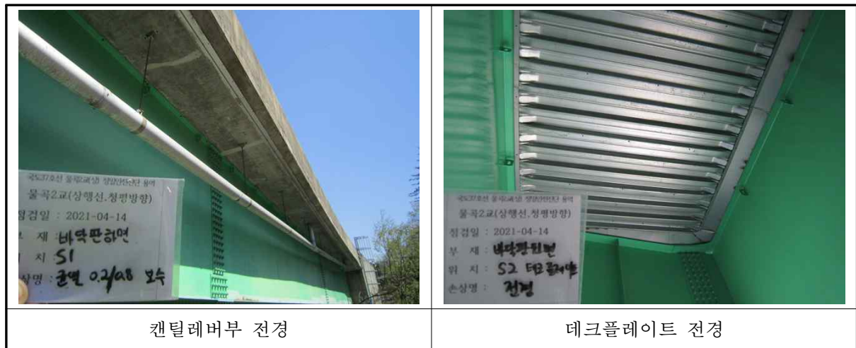
〈사진 3.11〉 바닥판하면 전경
