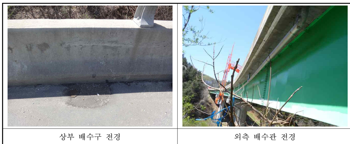
〈사진 3.6〉 배수시설 전경
