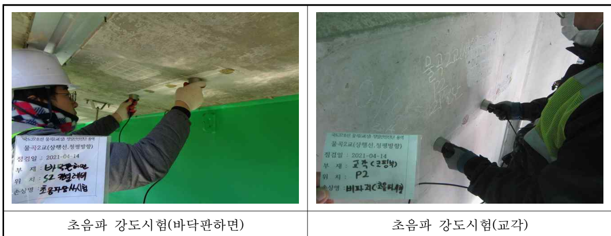
<사진 3.24> 초음파시험 측정 현황
