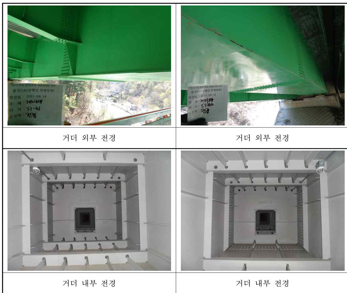
〈사진 3.13〉 거더 전경
