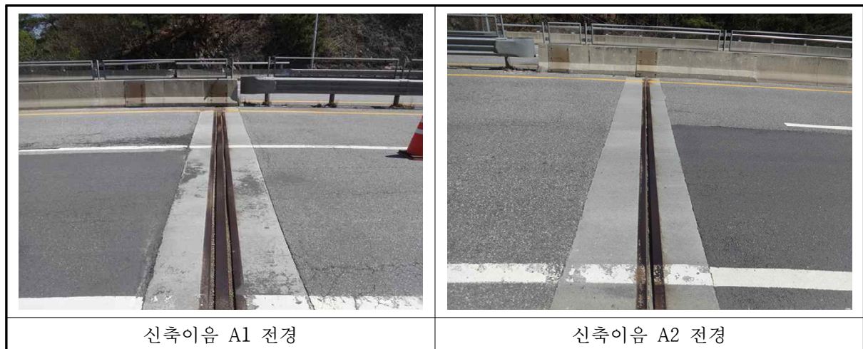
〈사진 3.8〉 신축이음 전경
