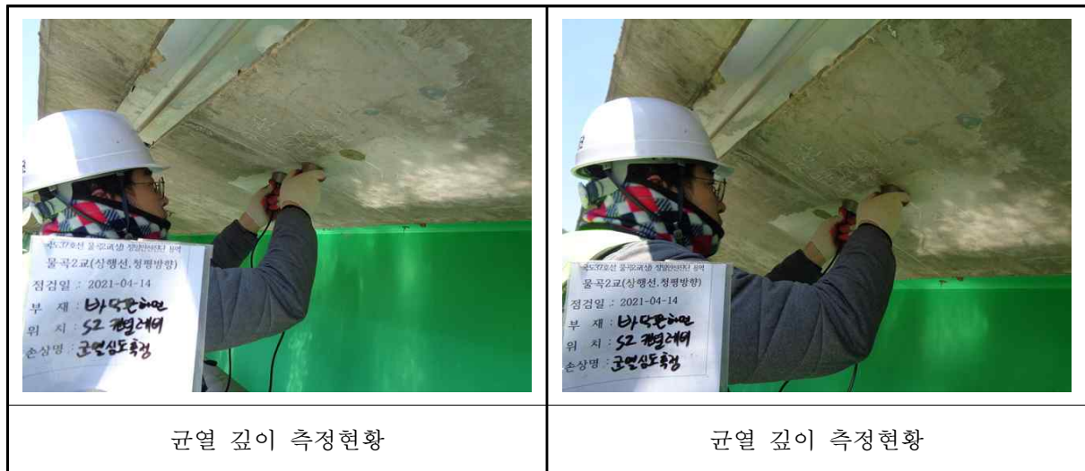
〈사진 3.28〉 균열 깊이 측정현황
