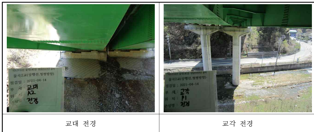
〈사진 3.19〉 교대 및 교각 전경
