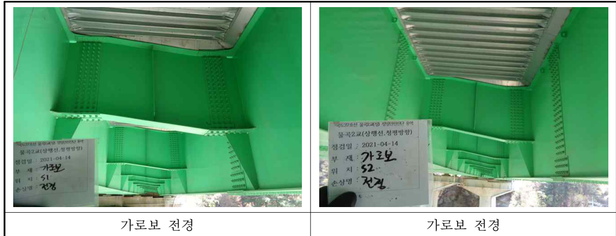
〈사진 3.15〉 가로보 전경
