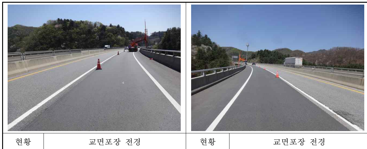
〈사진 3.2〉 교면포장 전경
