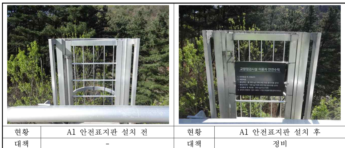
〈사진 3.22〉 부대시설 외관조사결과
